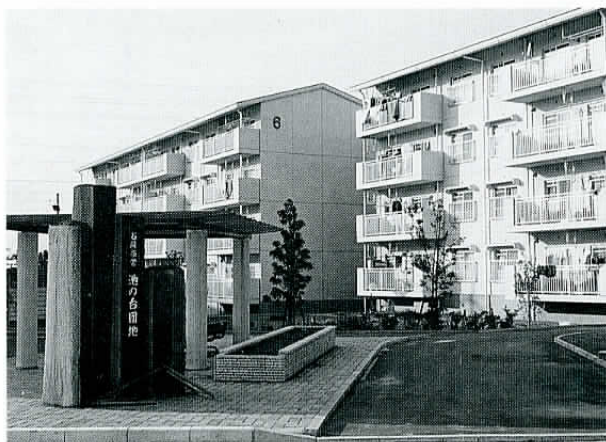
▲着々と建設が進む市営池の台団地。
