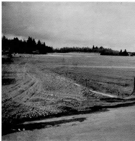
完成がたれるスポーツ広場 (小井戸運動広場にて)
