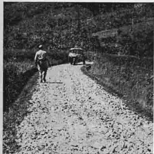
朝日林道第1期工事終点付近
