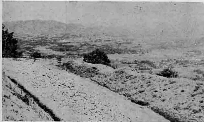
湯袋林道と朝日林道の第一期中工事は、一月ははじめから塚谷建設の請負で工事がすすむ。湯袋林道は、風返峠から湯袋に向けて三百六十メートル。工費百三十万。
