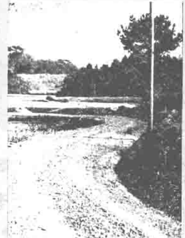
改修された町道 = 片岡地内 =
