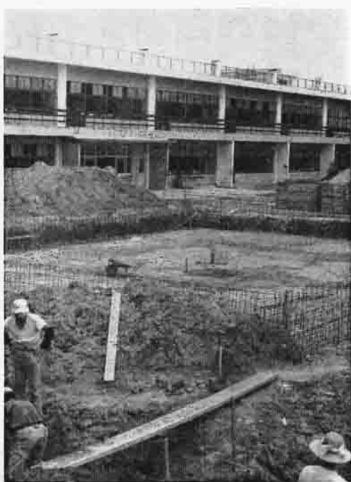
柿岡中に建設中のプール
