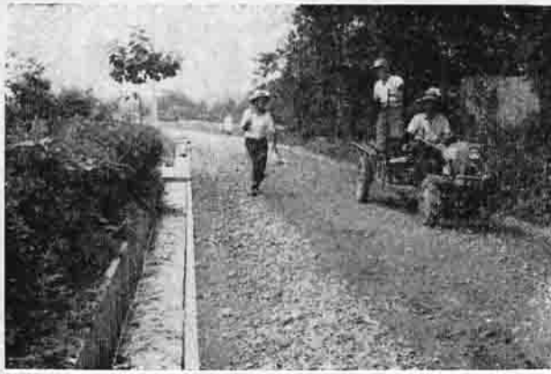
(改良された道路 一吉生上根地内一)
