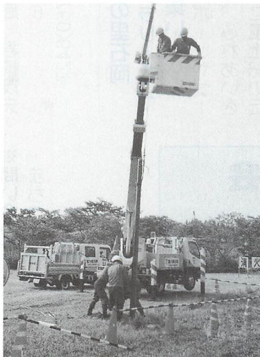
▲電力復旧活動
