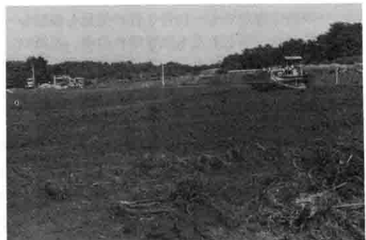
吉生小の造成工事現場
