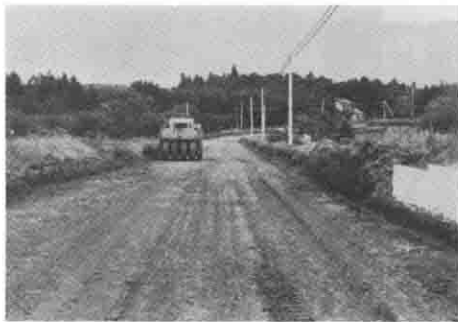
改良工事の行われている芦穂7号線
