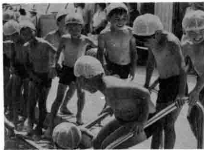
完成したプールで大喜びの子供たち
