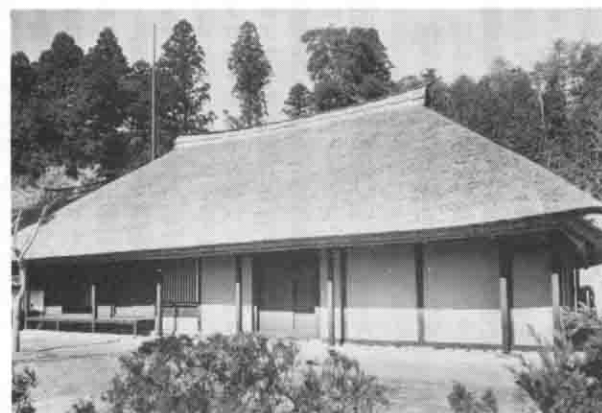
▷解体修理後の建物
