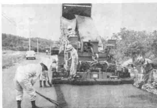
◀ 瓜谷地内の舗装工事
