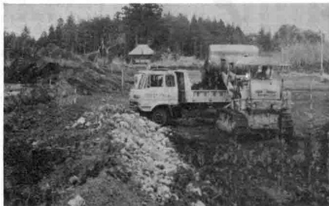
完成もまじかい造成工事現場
