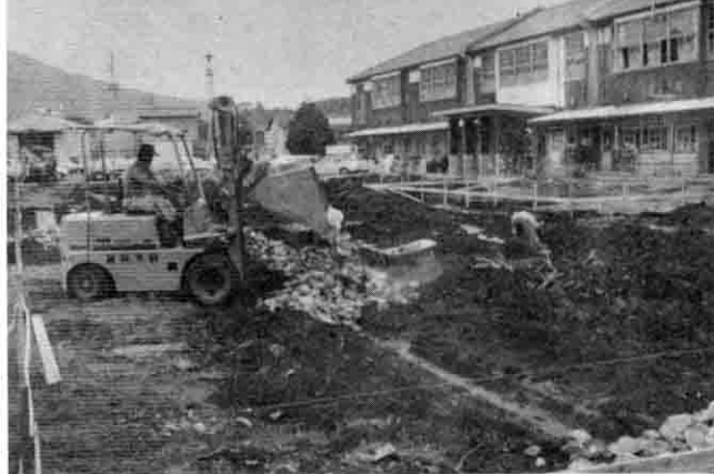
恋瀬保育所の建築工事現場
