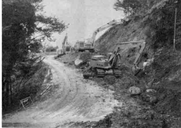
町道湯袋線の改良工事現場
