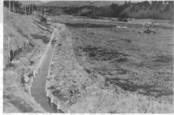
△ 恋瀬川上流地区土地改良事業 (下林里地内で)
