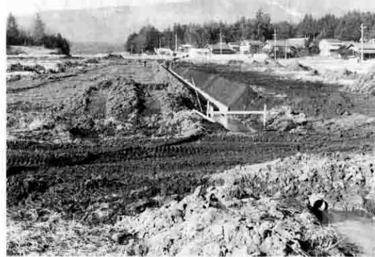
区画整理工事の進む村子地内の水田（3ha）。今年の春は、集団転作で大豆が作られる予定。
