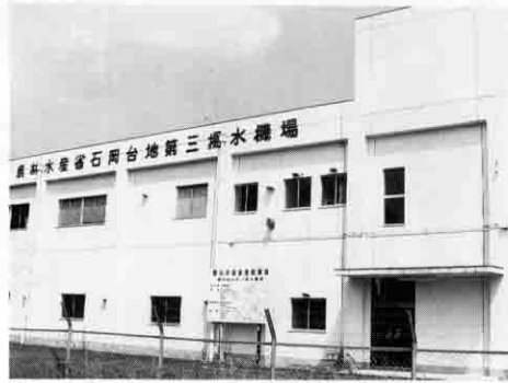
真家にある揚水機場
