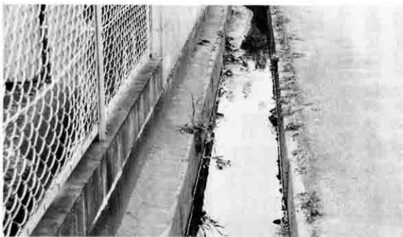
汚れた雑排水が流れる排水路
