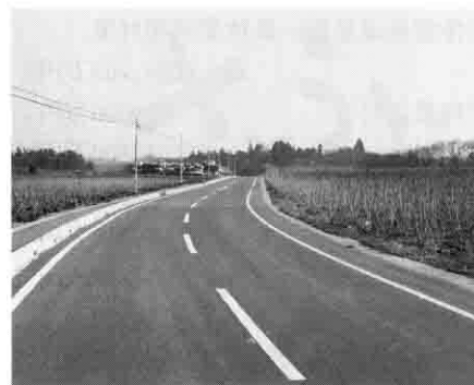
町道飯塚山崎線の改良舗装の一部が完成(下林地内)
