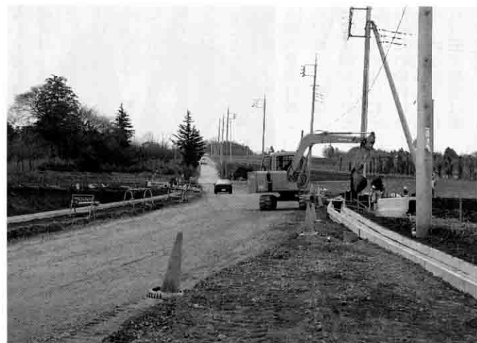
急ピッチで整備が進められる町道飯塚山崎線
