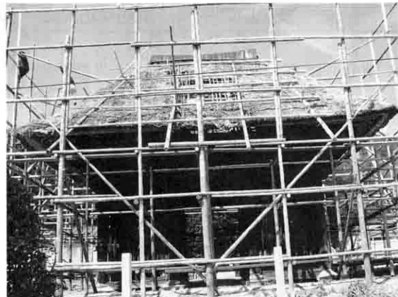
善光寺楼門の解体修理
