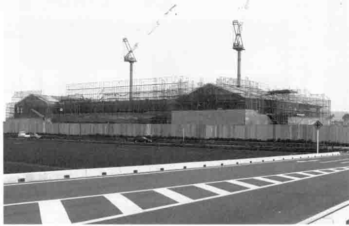
躯体工事が進む新庁舎
