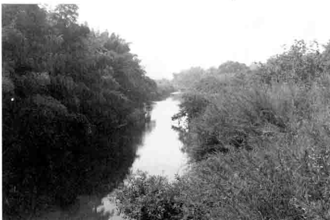
大雨になると不安な恋瀬川（半田地内）
