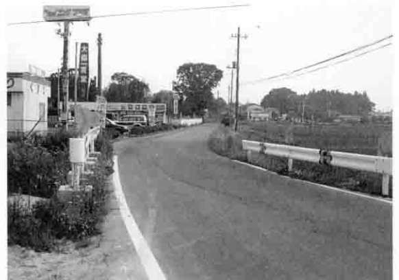
庁舎建設に合わせて整備が待たれる周辺道路
