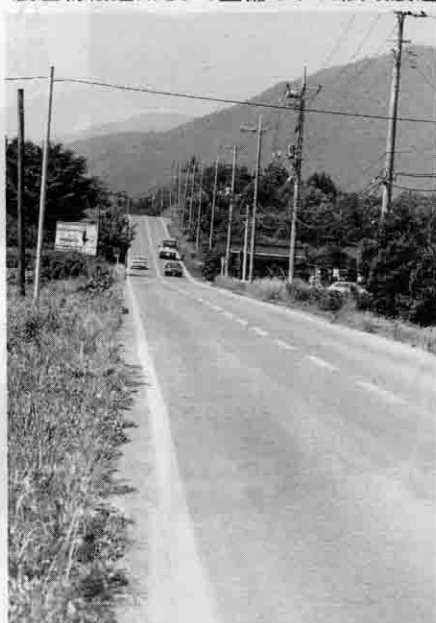
農産物輸送路として整備された広域農道
