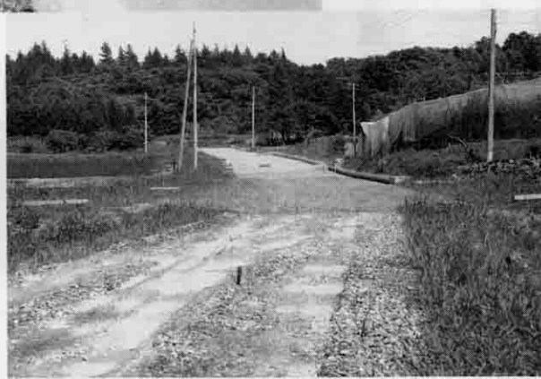
県道のバイパス工事がすすめられている川又地内
