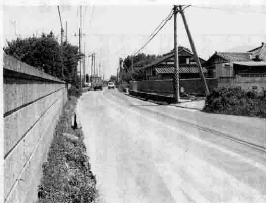
国道355号東成井地内
