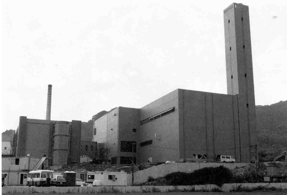
平成7年4月から稼働する新しいゴミ処理施設
