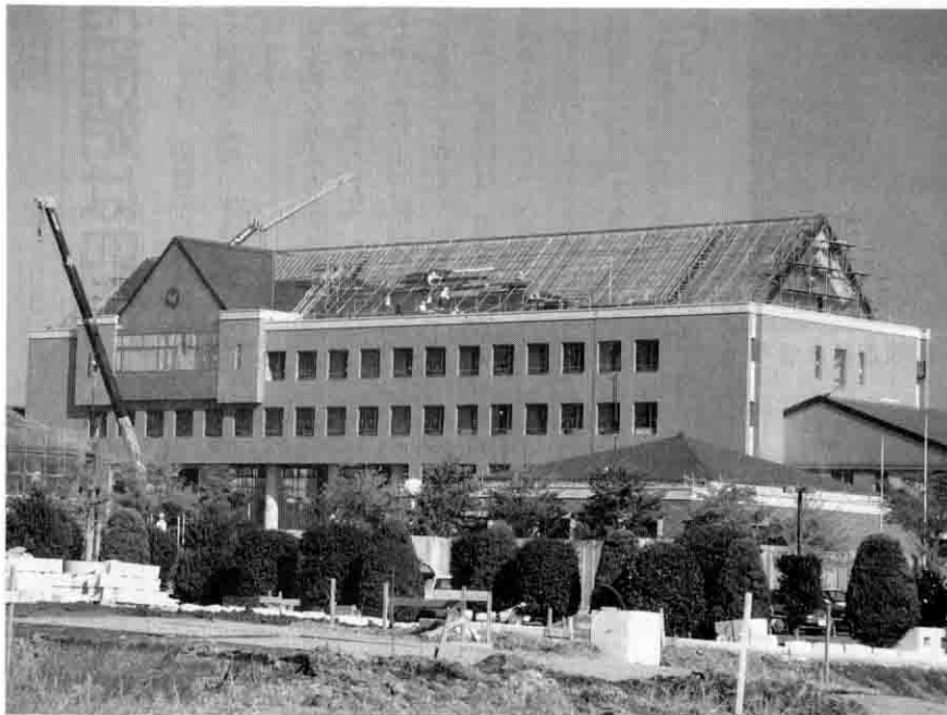
完成間近かの新庁舎、駐車場の整備も同時進行
