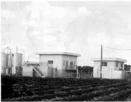
8年度は下林浄水場施設や配水管整備が行われました
