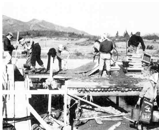
遠江戸橋(町道柿岡〜小幡線) 架替え工事。工事の様子も現在と はちよつとちがいます。 (昭和三十四年十二月)
