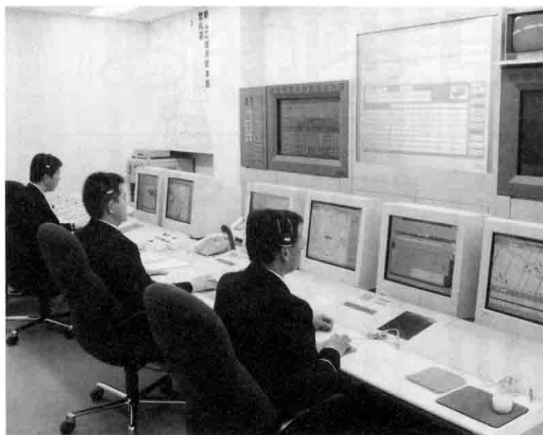
消防車両動態管理・119番受報システム・無線通信網・医療機関情報・象情報など消防活動情報を一元管理しています
