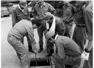
↑消火栓の点検。ここから水を供給します。
