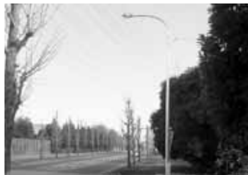
▲工業団地内に新設された街路灯
