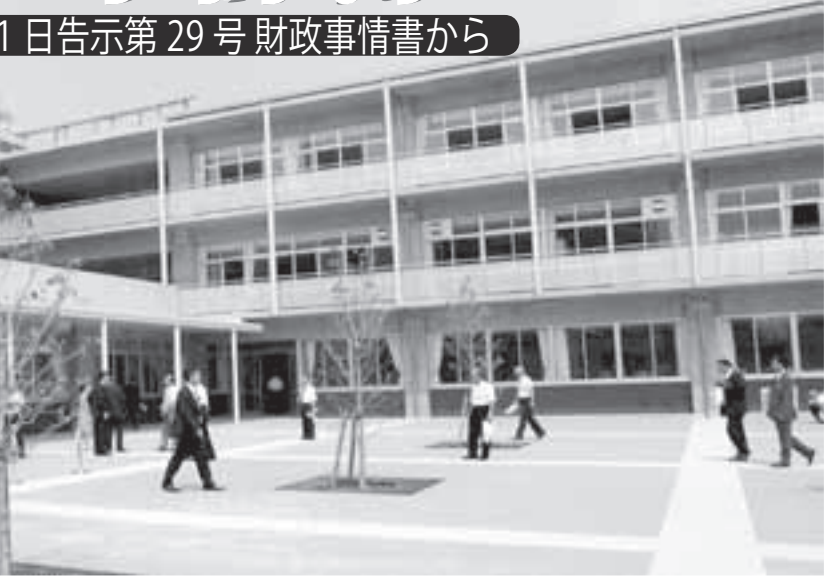
東小学校竣工(平成22年8月26日)
