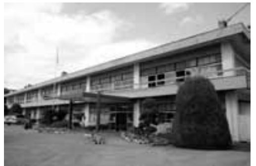
校舎改築工事に着手する柿岡中学校
