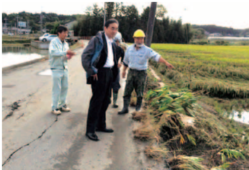
▲台風18号の影響で道路の法面が崩落した片野地区
