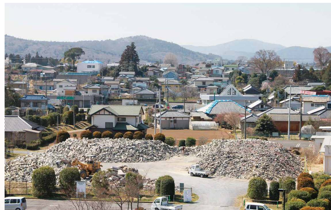
ブルーシートで屋根を覆う家が至るところにあった
