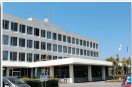
▲10月から解体を開始した本庁舎
