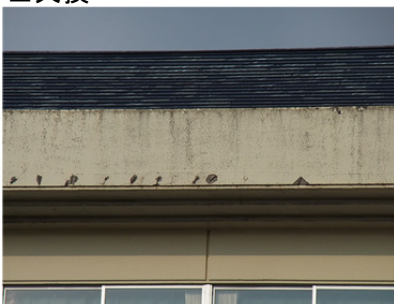
園部中学校 外壁
