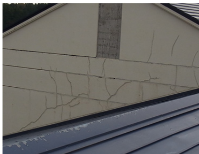
園部中学校 外壁
