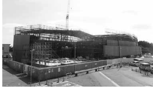
工事が進む新庁舎建設事業
