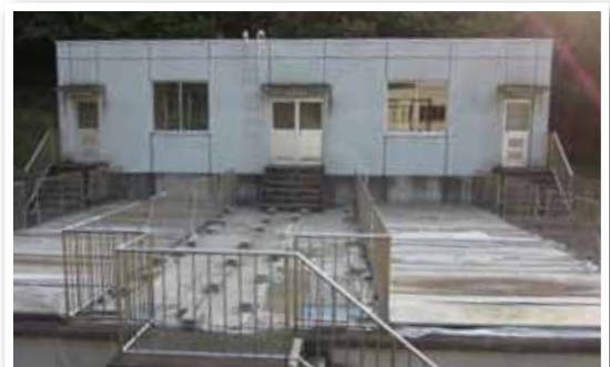
▲浄水場の配水池
