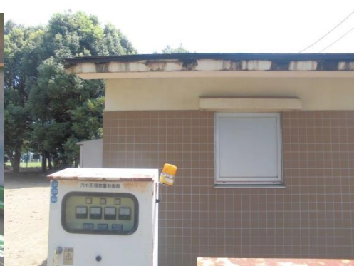
（サッカー公園：トイレ建屋）
