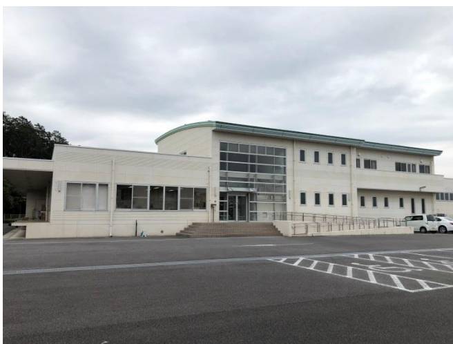
【石岡学校給食センター全景】
