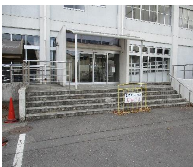
管理棟への入口
