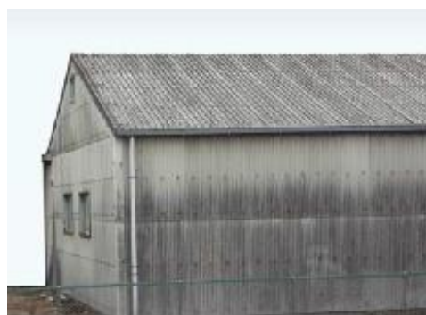
石綿含有スレート波板（屋根・外壁）
