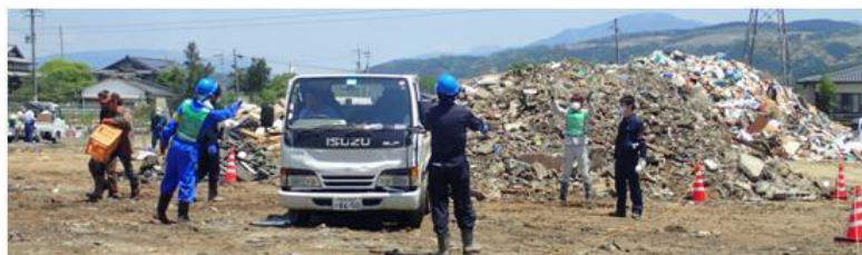
作業員の配置
