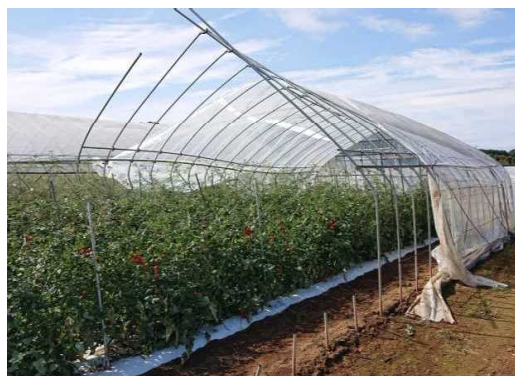
図-4 風の吹き込みにより内側から外側に破裂するパターン
