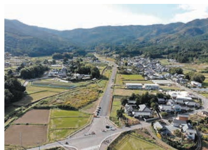
▲トンネル取付道路の上空撮影
