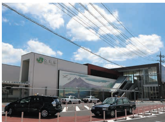
▲石岡駅西口側から見た駅舎
