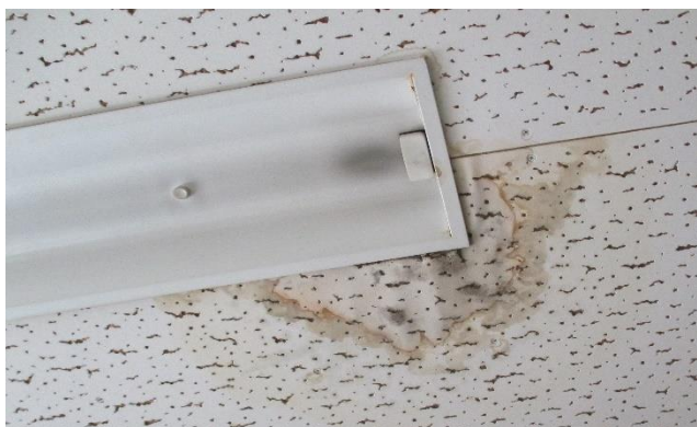
2階大調理室前北側廊下の蛍光灯付近に雨漏り跡。(写真左)
