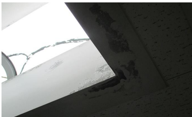
2階北側階段天窓付近に塗装剥がれがみられる。(写真左)
