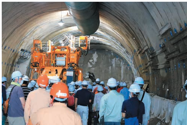
▲掘削工事の行く手を阻む花崗岩の硬い岩盤。爆薬を使った発破掘削を24時間体制で行い、少しずつ掘り進んでいきます。トンネル開口部には騒音・振動対策として、二重の防音扉が設置されています。
