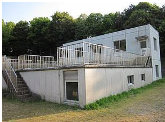
【中央浄水場ろ過池】
