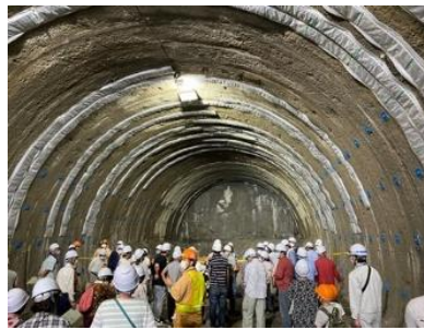
【上曾トンネル本体工事の様子】
