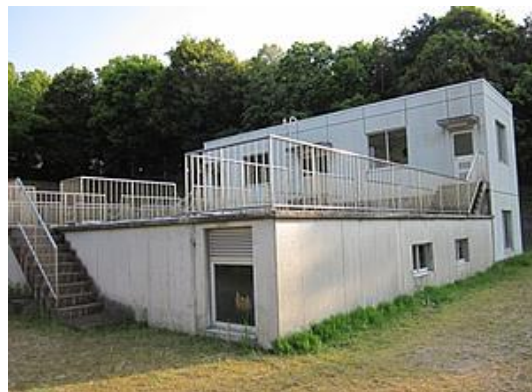
【中央浄水場ろ過池】
