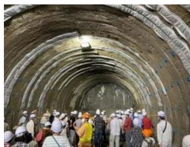
【上曽トンネル本体工事の様子】
