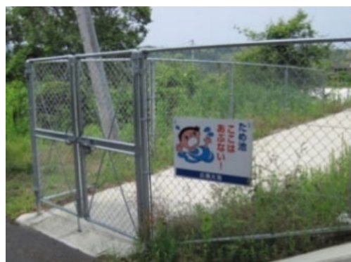
進入防止フェンスの設置
