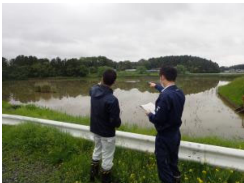
ため池の点検
