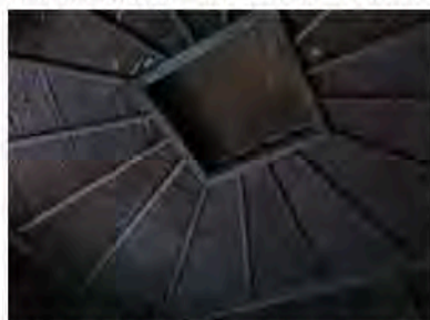
▲天井を唐傘天井とする丁寧な造り
