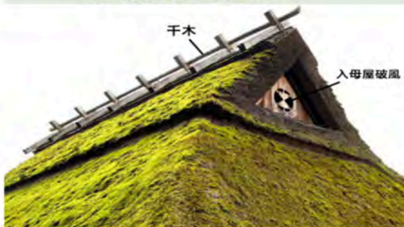
換気口：家紋の透かし彫り
