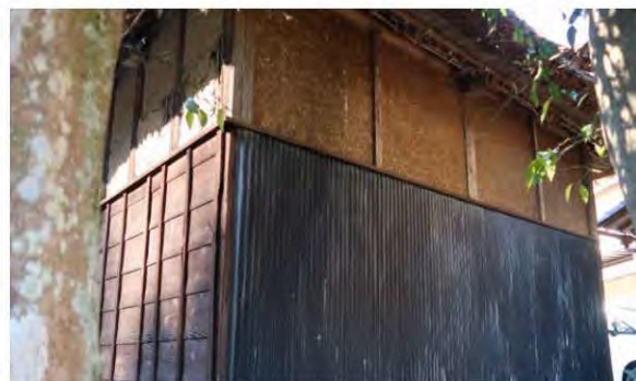
▲東側室の外部からみた柱の様子 (②)
