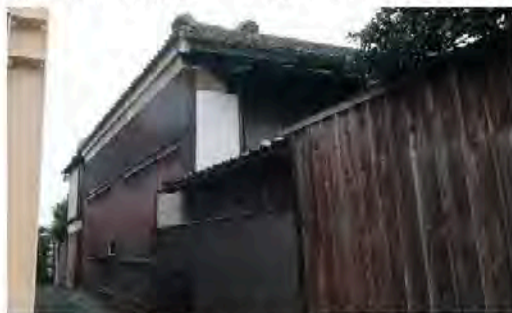
▲離れの西側壁面は漆喰で延焼対策を行っている
