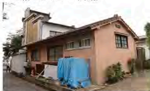
▲昭和 35 年頃に建て替えられた
