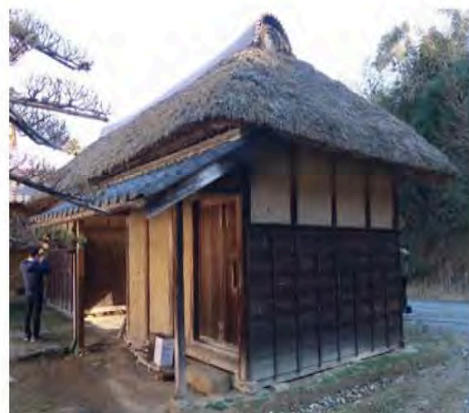
▲西側室の土庇の様子
