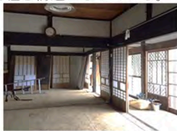
▲写真⑥ 内装の様子
