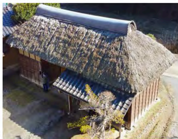
▲長屋門裏側（ドローンにて撮影）
