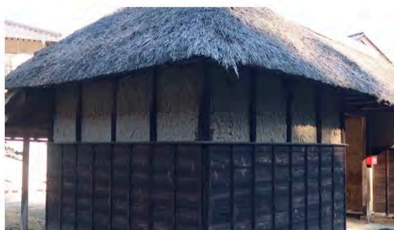
▲西側室の外部からみた柱の様子 (①)
