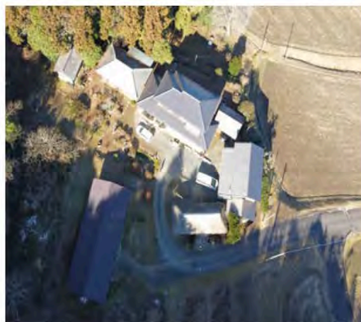
▲敷地全景（ドローンにて撮影）
